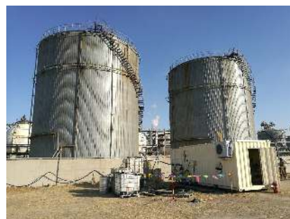
图2 现场应用照片
