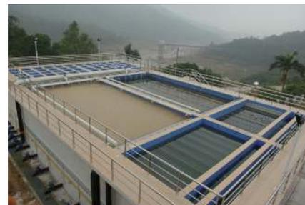
图5 珠海三灶水厂改造工程新型气浮-沉淀工艺构筑物外观
