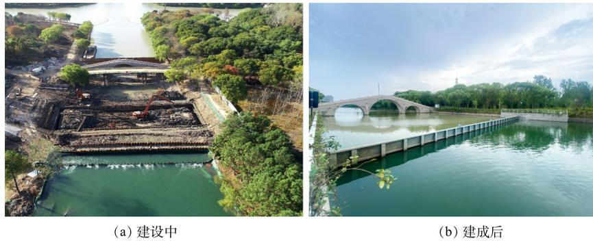
图3 长盐塘钢坝建设中和建成后现场照片
